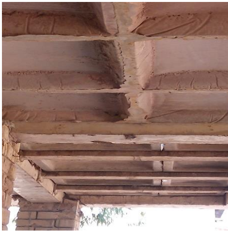
Ujenzi wa Sakafu za ghorofa au paa kwa kutumia teknolojia ya “Laadies na waffles”
